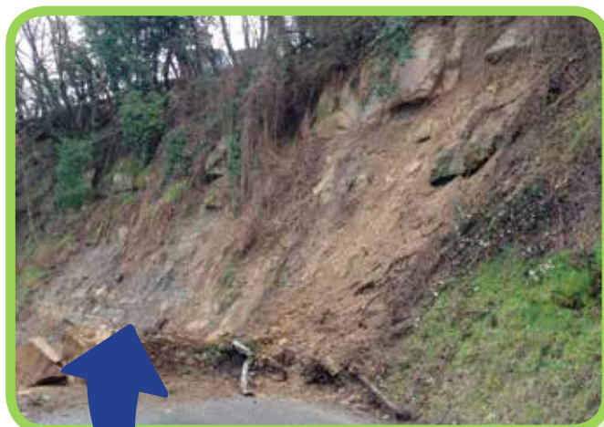
Frana in un versante appenninico, causata dall'erosione delle piogge su rocce fragili
