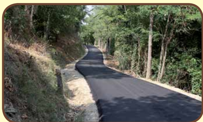
Ripristino della viabilità locale
