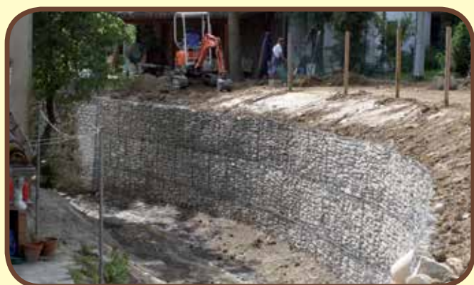
Consolidamento di scarpata in frana
