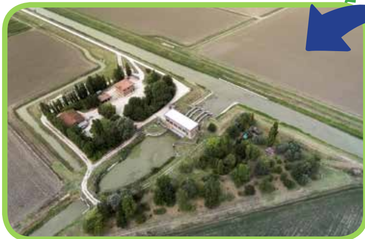
Impianto idrovoro Tratturo vista aerea
