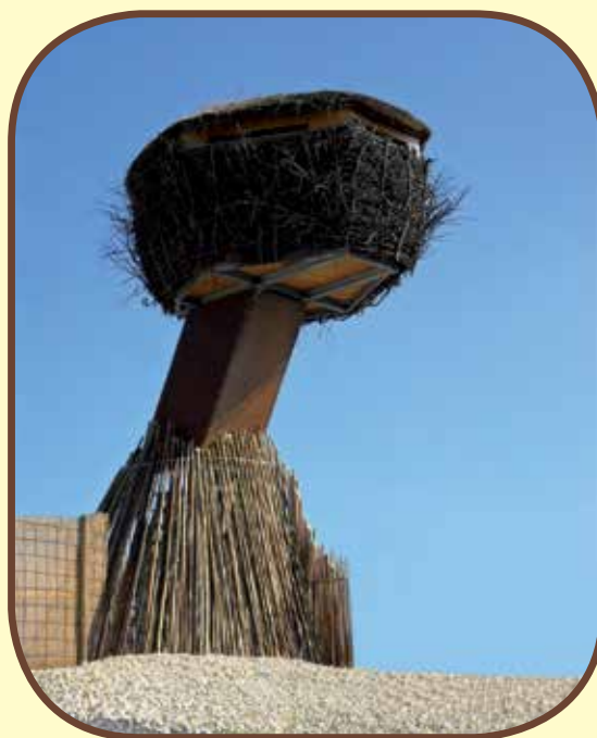
Torre di avvistamento sulla cassa di espansione Gambellara, a forma di nido
