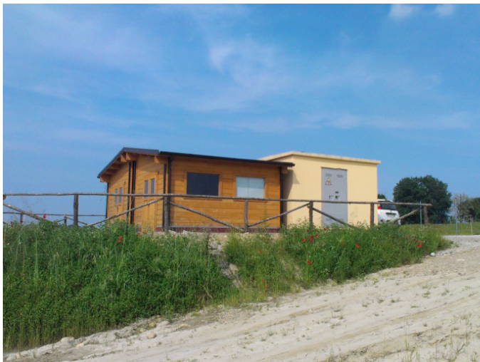
Vista fabbricato in legno per locali tecnologici e cabina in cemento per gestione fornitura elettrica
