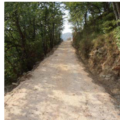
Lavori ultimati - tratto che resta a fondo bianco
