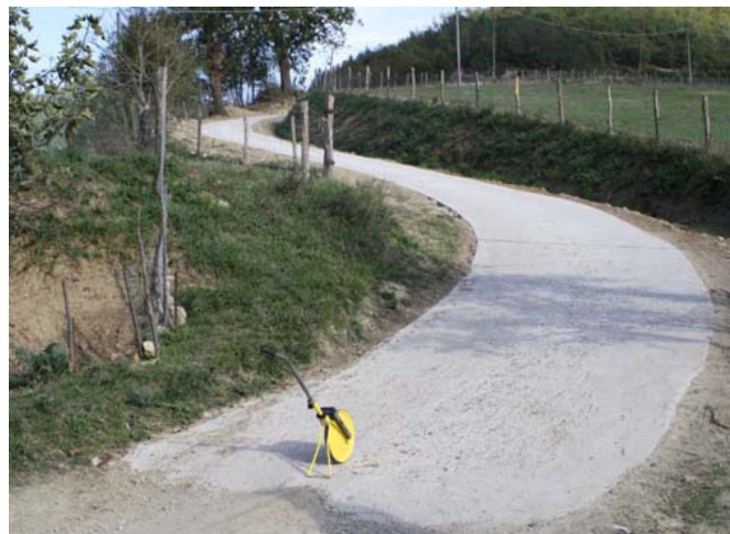
Quarto tronco - Lavori ultimati
