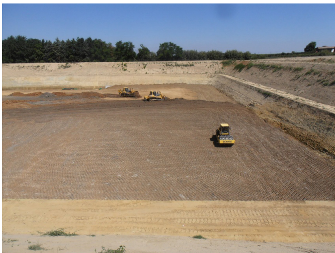
Lavori di impermeabilizzazione del fondo invaso
