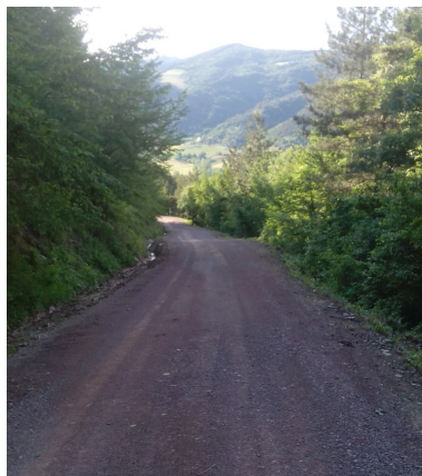
Ricarico della massiciata stradale con stabilizzato di cava
