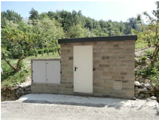
Stazione di rilancio in linea delle condotte di distribuzione irrigua
