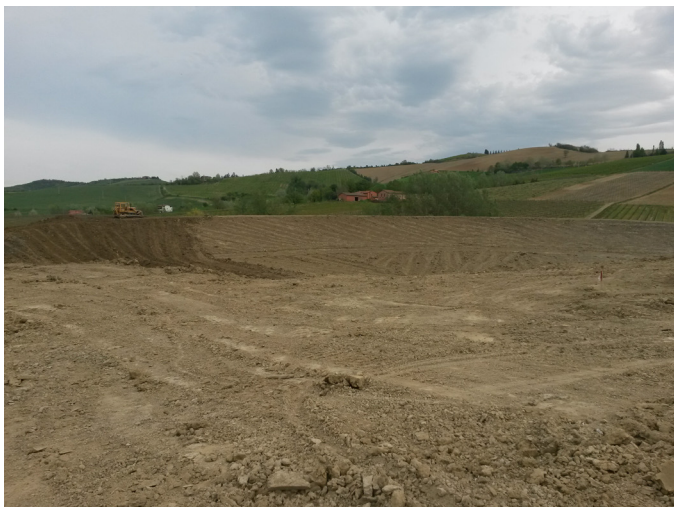
Fasi di scavo dell'invaso in Loc.Ca' Nova
