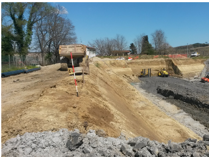
Realizzazione fondo invaso, sullo sfondo posa dei pozzi per pompe sommerse
