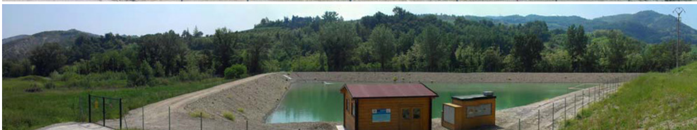
Viste panoramiche dell'invaso e dei fabbricati in legno per gli impianti tecnologici
