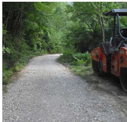
Lavori in corso - rullatura stabilizzato
