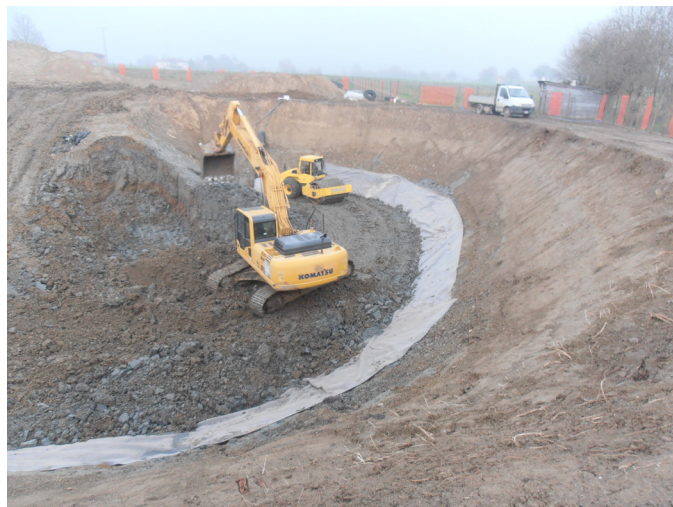
Lavori di impermeabilizzazione dell'invaso
