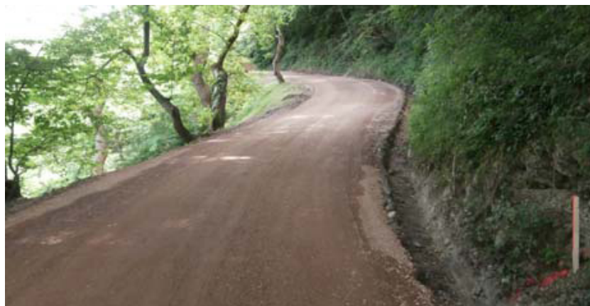
Strada del Vinco a seguito dei lavori di ghiaiatura con stabilizzato compattato
