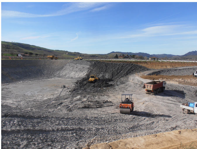
Realizzazione della sponda sud-ovest dell'invaso
