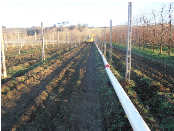
Fase di posa della condotta in PVC biorientato
