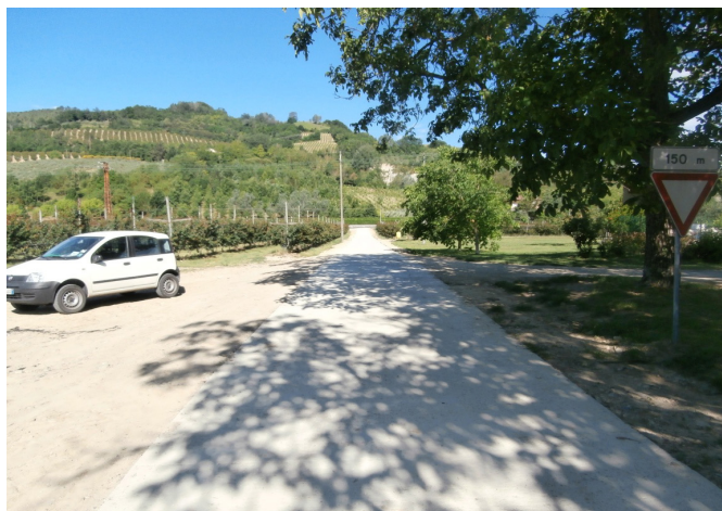
Tratto stradale pavimentato con cls
