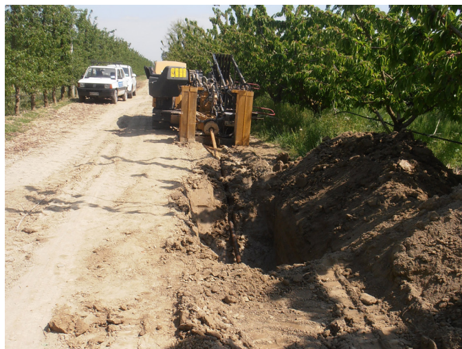
Trivellazione Orizzontale Controllata
