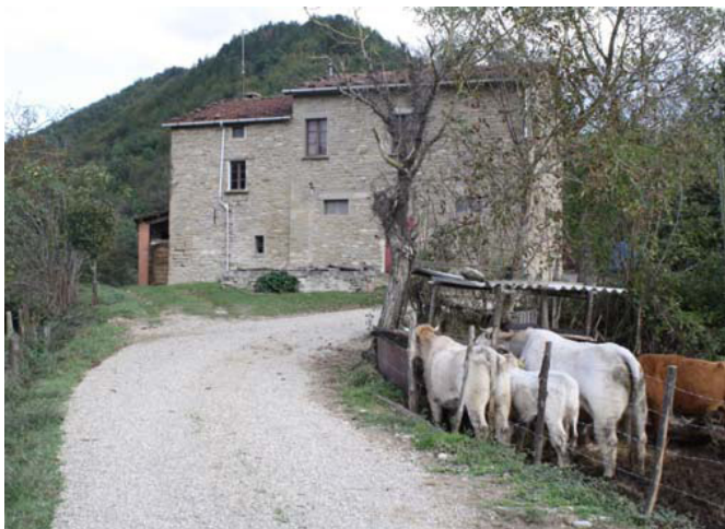
Secondo tronco - Lavori ultimati
