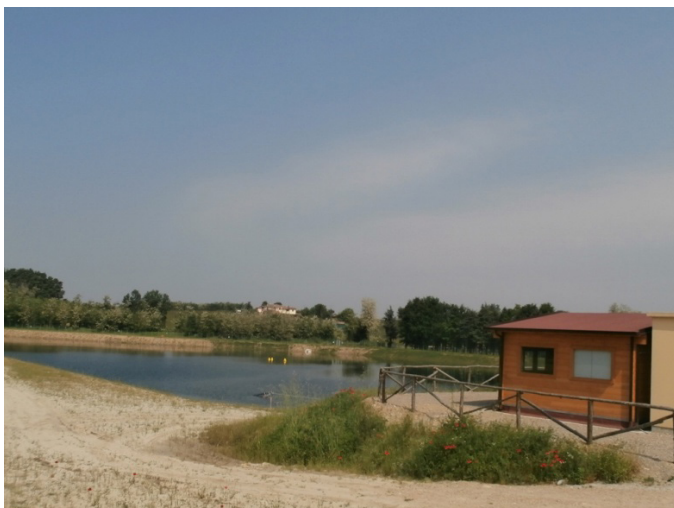
Panoramica dell'invaso e del fabbricato degli impianti tecnologici
