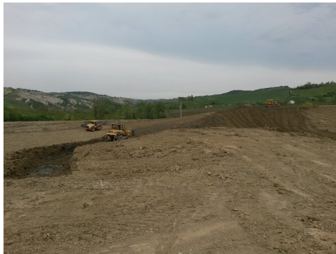
Fasi di scavo dell'invaso in Loc.Ca' Nova
