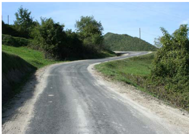
Tratto stradale pavimentato con binder
