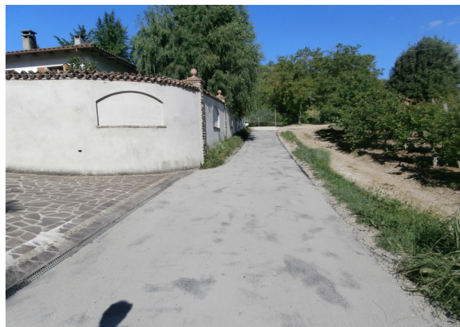
Tratto stradale pavimentato con binder
