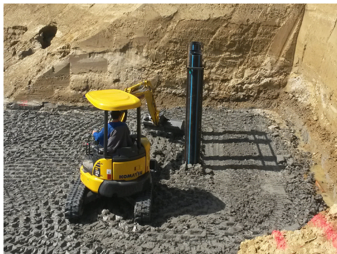
Realizzazione pozzi per alloggiamento pompe sommerse
