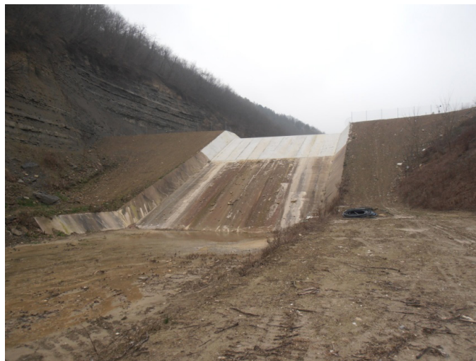
Lavori di costruzione dell'alzamento della diga - vista valle
