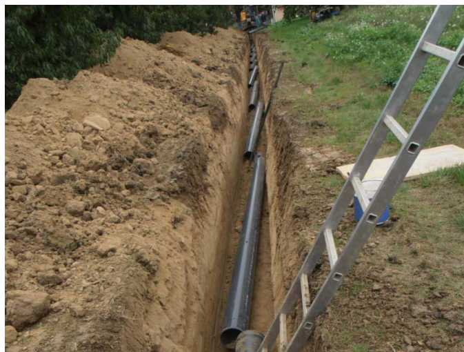
Posa delle condotte in pressione in PVC
