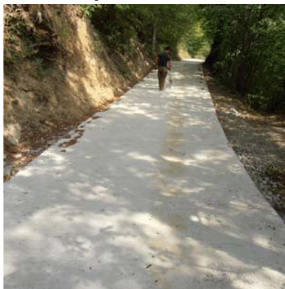
Lavori ultimati - tratto con conglomerato cementizio
