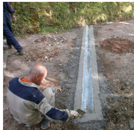
Lavori in corso - realizzazione tagliacque
