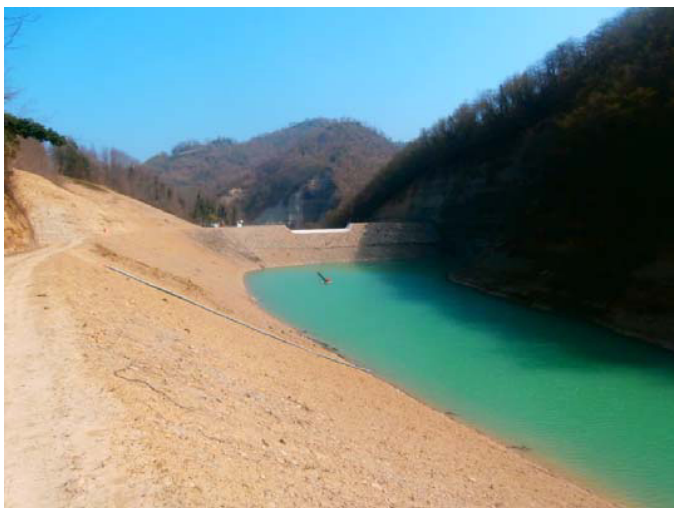
Ampliamento dell'invaso con alzamento della diga in terra - lavori ultimati
