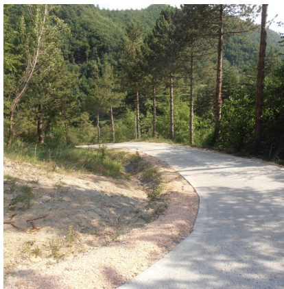
Lavori ultimati - tratto con conglomerato cementizio
