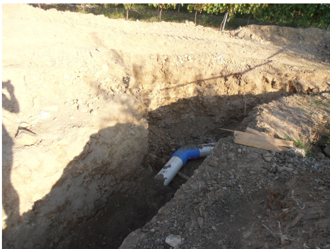
Fase di preparazione per il getto della curva in PVC biorientato
