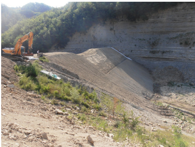
Lavori di costruzione dell'alzamento della diga - vista monte
