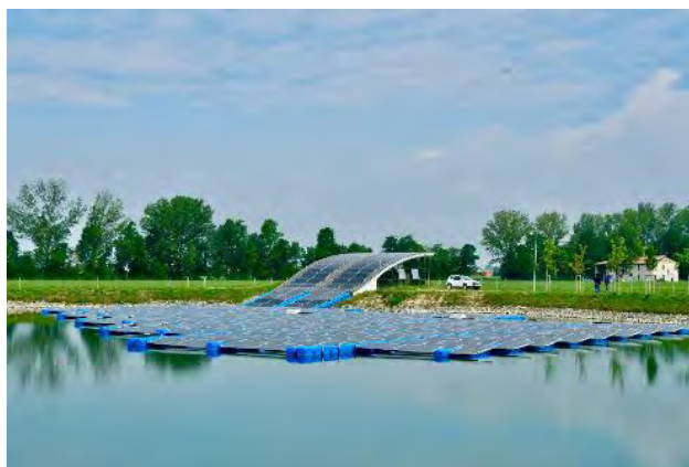
Impianto fotovoltaico centrale Santa Lucia
