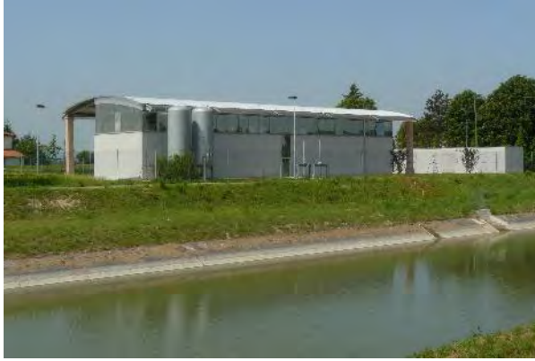
Centrale San Severo
